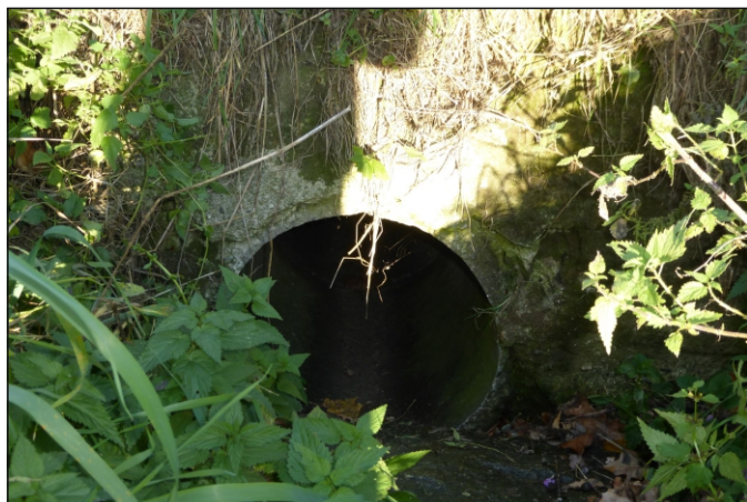
Propustek 15c - staničení 0,032 - pohled zleva
