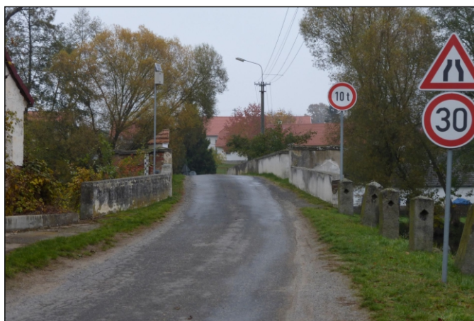
Most 27c-M1 - staničení 0,352 - celkový pohled
