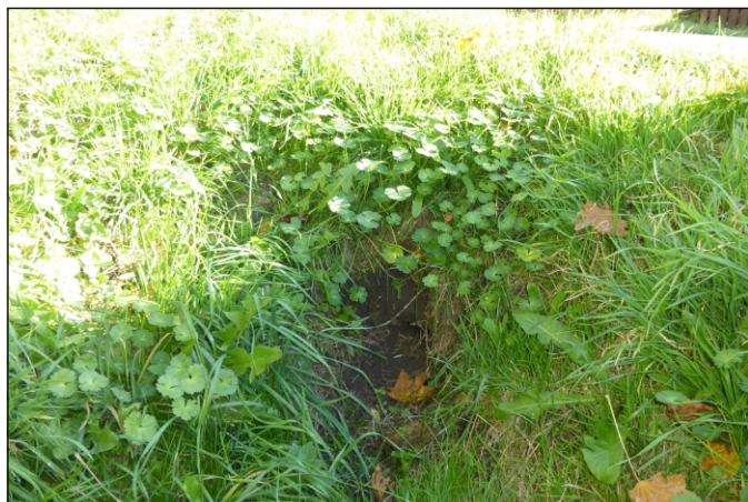
Propustek 4c - staničení 0,655 - pohled zleva
