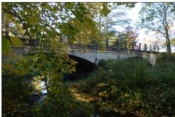
Most 8c-M2 - staničení 1,144 - pohled zprava
