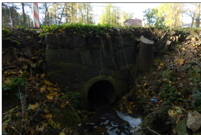
Propustek 15c - staničení 0,350 - pohled zleva
