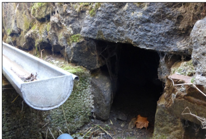
Propustek 4c - staničení 0,655 - pohled zprava
