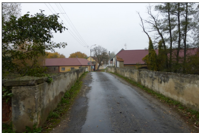
Most 27c-M1 - staničení 0,352 - celkový pohled
