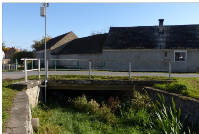
Most 8c-M1 - staničení 0,133 - pohled zleva
