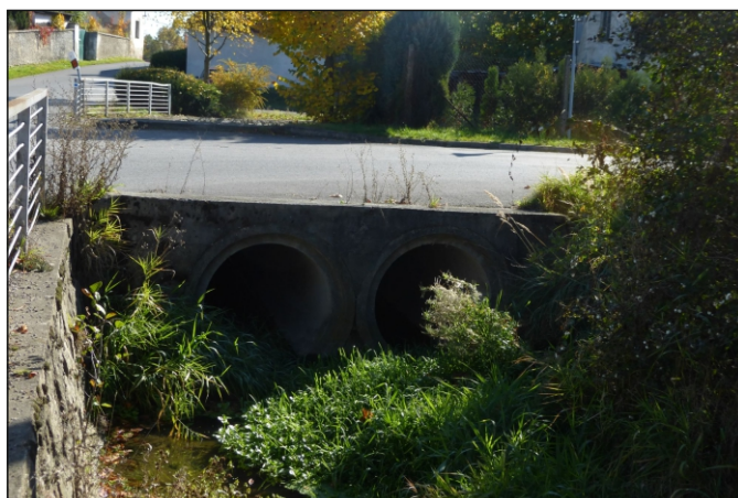
Propustek 3c - staničení 0,390 - pohled zleva
