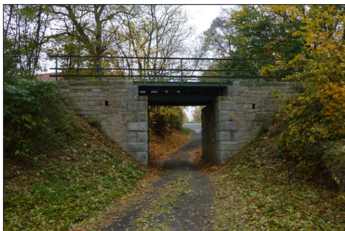
Podjezd 28c-P1 - staničení 0,061 - pohled zezadu
