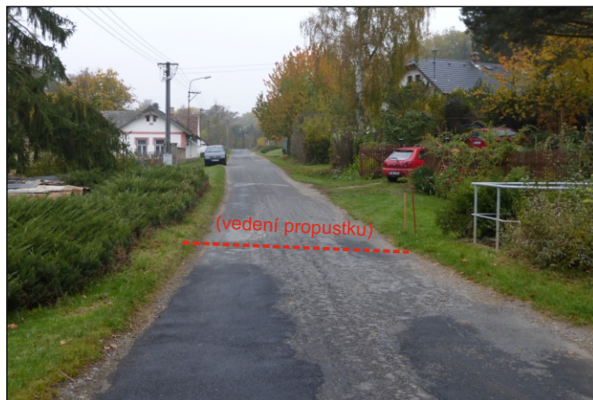
Propustek 27c - staničení 0,916 - celkový pohled
