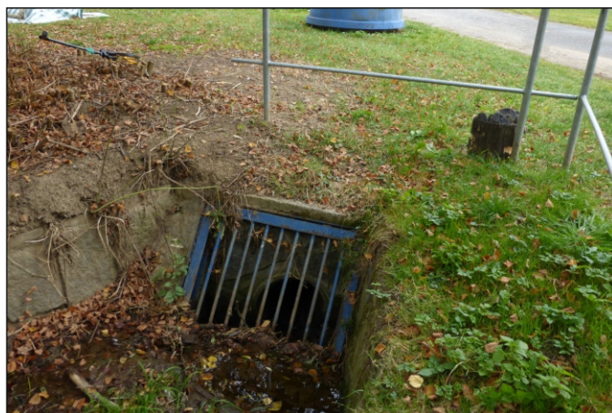
Propustek 28c - staničení 0,0187 - pohled zleva
