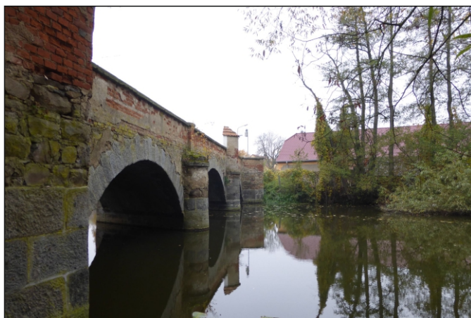
Most 27c-M1 - staničení 0,352 - pohled zleva
