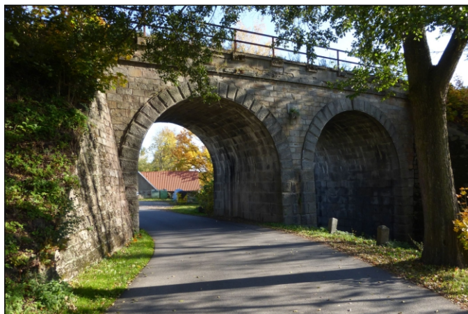
Podjezd 8c-P1 - staničení 0,580 - pohled na oba oblouky
