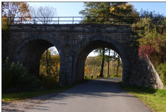
Podjezd 8c-P1 - staničení 0,5875 - pohled zezadu
