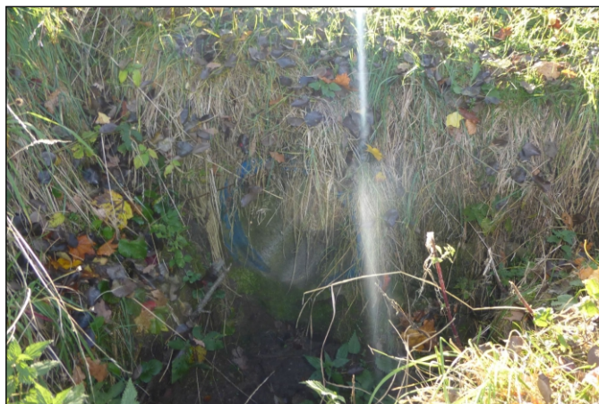
Propustek 15c - staničení 0,032 - pohled zprava
