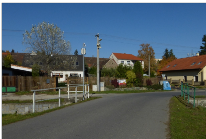
Most 8c-M1 - staničení 0,133 - celkový pohled
