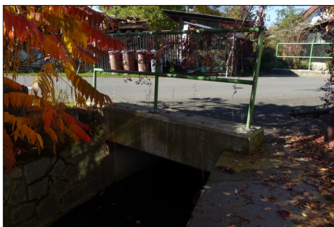
Most 4c-M1 - staničení 0,302 - pohled zprava
