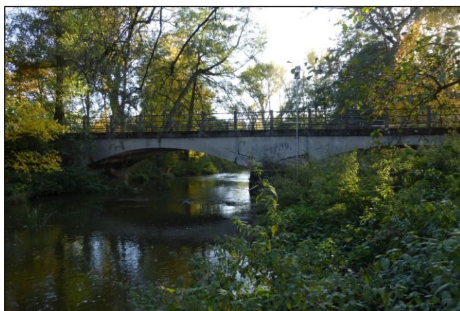
Most 8c-M2 - staničení 1,144 - pohled zleva
