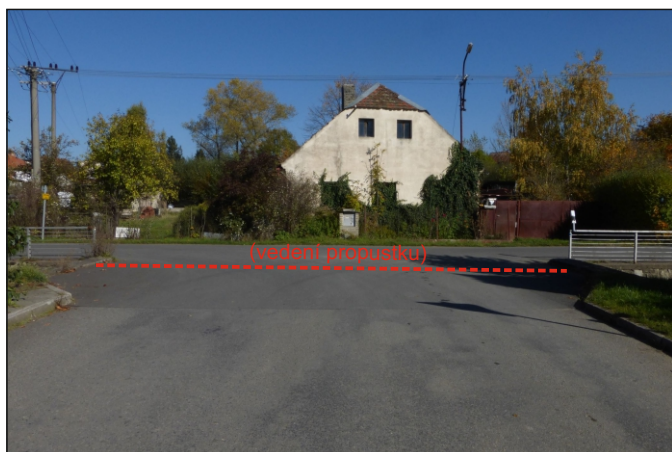
Propustek 3c - staničení 0,390 - celkový pohled
