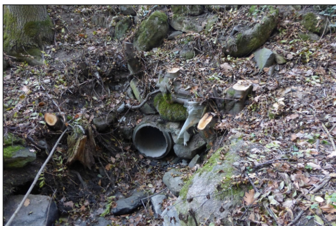
Propustek 15c - staničení 0,318 - pohled zleva
