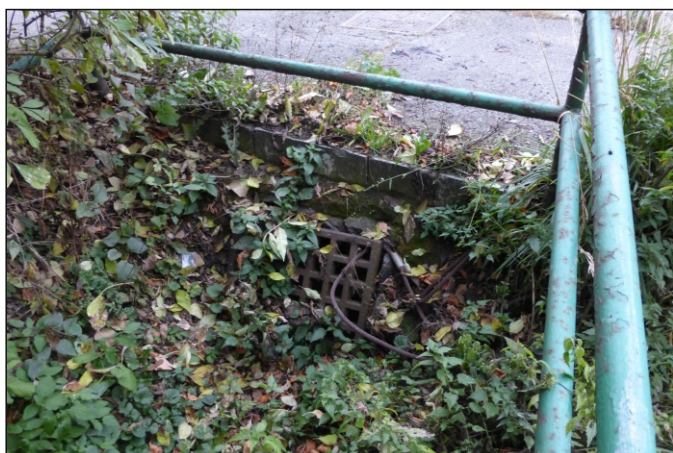
Propustek 4d - staničení 0,940 - pohled zprava
