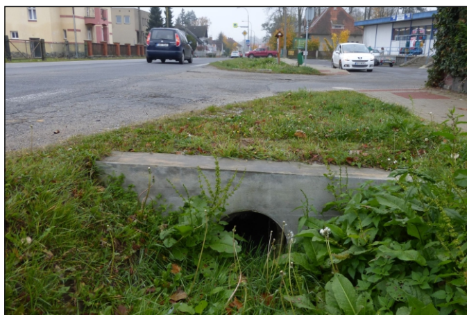
Propustek 24c - staničení 0,042 - pohled zleva
