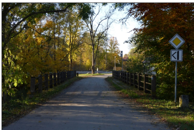
Most 8c-M2 - staničení 1,144 - celkový pohled
