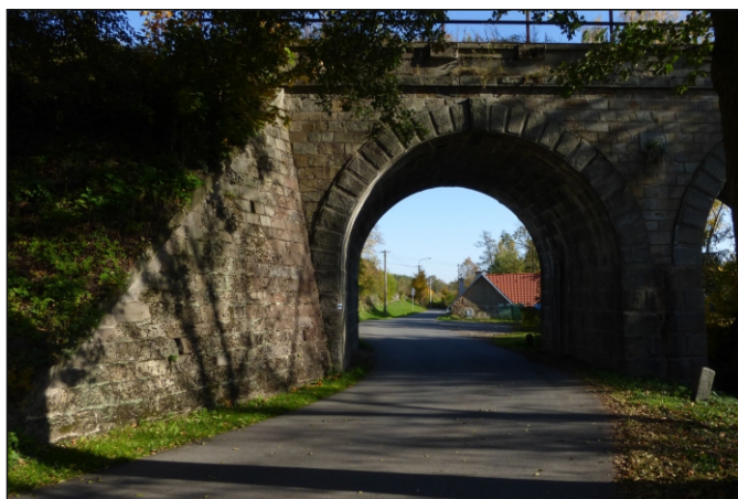
Podjezd 8c-P1 - staničení 0,580 - pohled na levý oblouk
