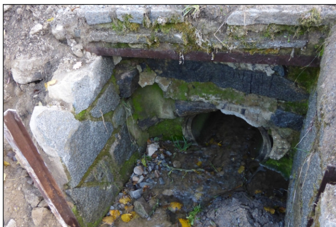
Propustek 15c - staničení 0,350 - pohled zprava
