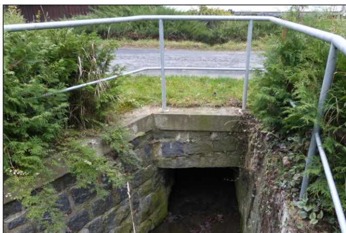
Propustek 27c - staničení 0,916 - pohled zleva
