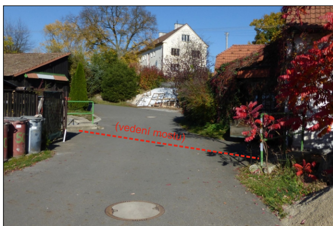
Most 4c-M1 - staničení 0,302 - celkový pohled
