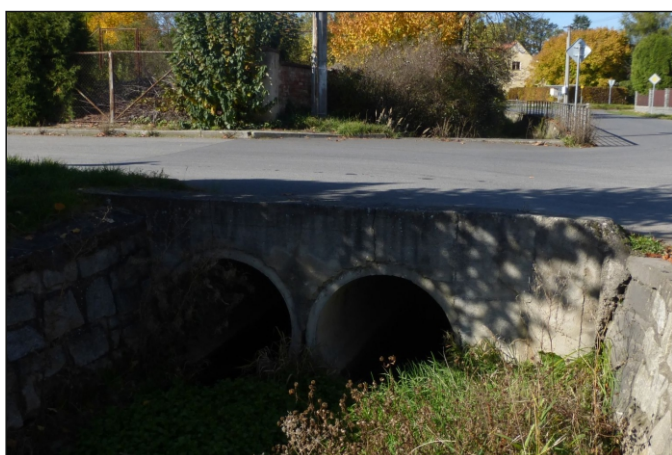
Propustek 3c - staničení 0,390 - pohled zprava
