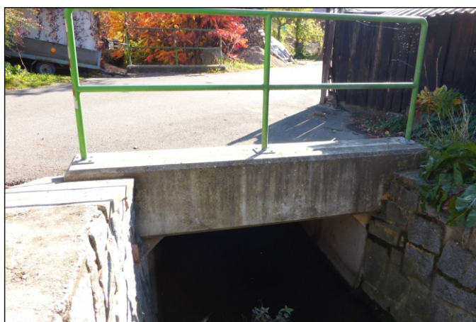
Most 4c-M1 - staničení 0,302 - pohled zleva
