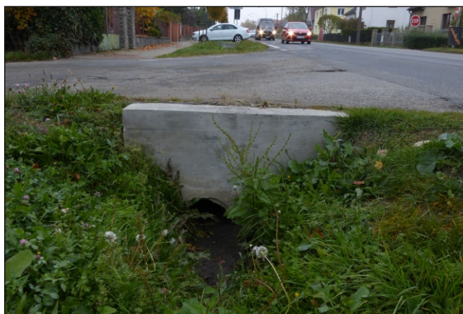
Propustek 24c - staničení 0,042 - pohled zprava
