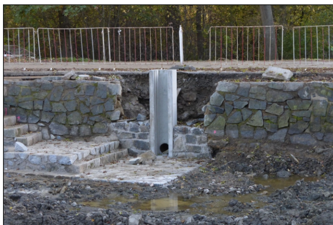
Propustek 15c - staničení 0,318 - pohled zprava
