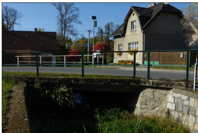
Most 8c-M1 - staničení 0,133 - pohled zprava
