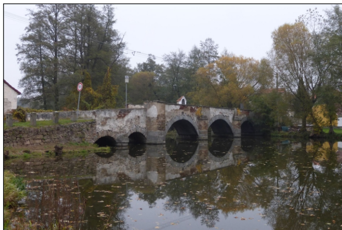
Most 27c-M1 - staničení 0,352 - pohled zprava
