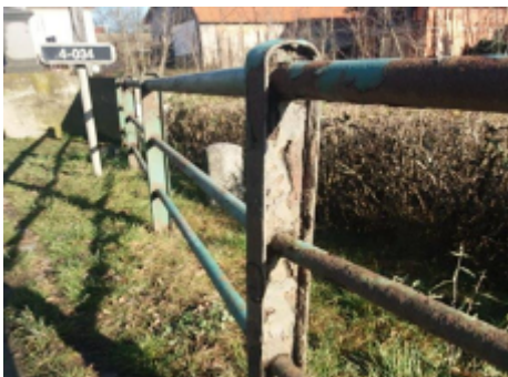
Výměna zábradlí po obou stranách a oprava chodníku
